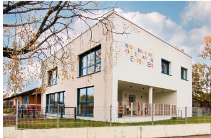
Bunte Buchstaben – bunt es Angebot: Die Kindertagesstätte in Wehringen wurde erweitert.
